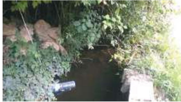
Photographies de l'ouvrage prise au cours de la prospection
