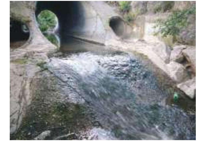
Photographies de l'ouvrage prise au cours de la prospection
