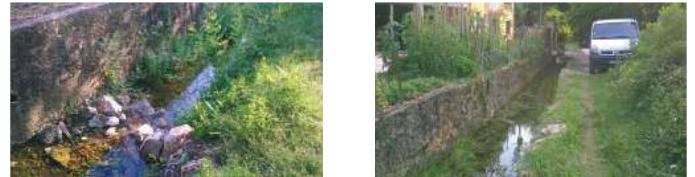
Photographies de l'ouvrage prise au cours de la prospection
