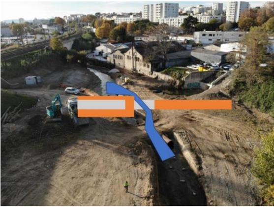
Phase 5 : Remblai des pas japonais rive gauche, retrait des batardeaux, remblai rive droite et remise en place du cours d'eau dans le lit définitif
