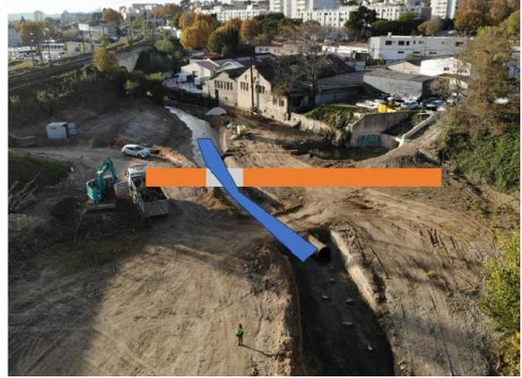
**Figure 91 : mode opératoire de mise en œuvre des pas japonais dans le lit de l'Huveaune sur le site Heckel à Marseille 11<sup>ème</sup>**
