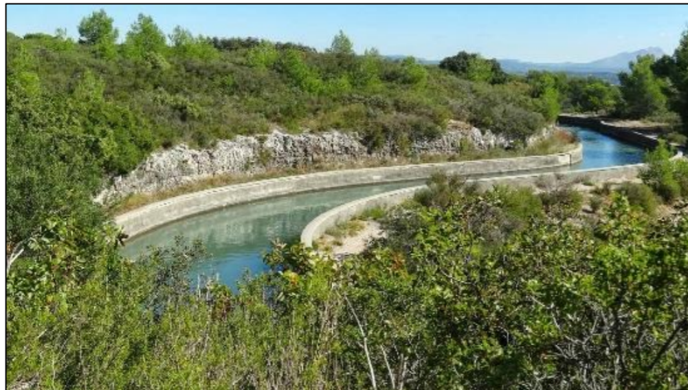
Figure 2 : Photo du Canal de Marseille (Src : https://www.toutsurmarseille.fr/1823/ )
